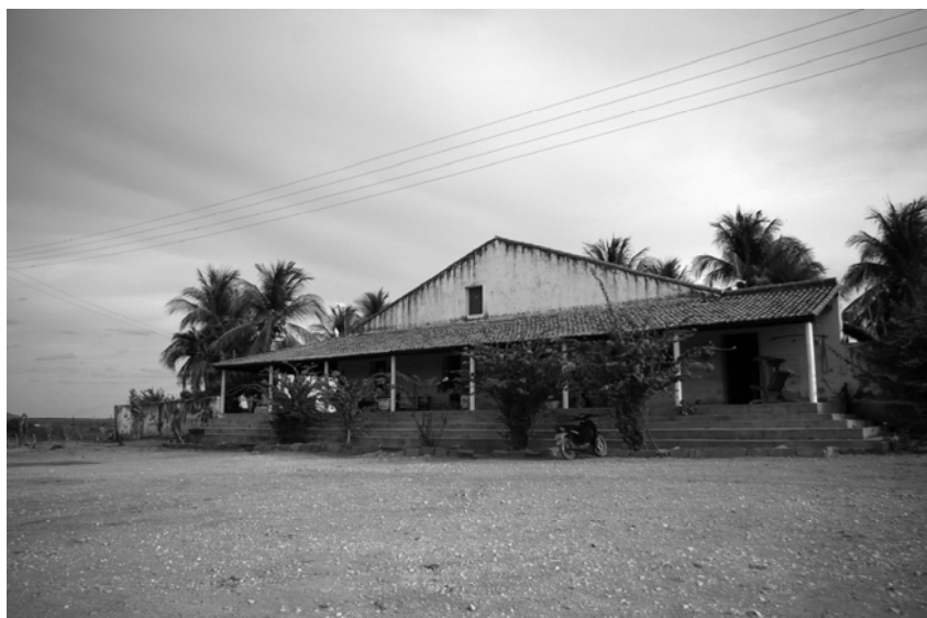
Foto 02 – Fachada e alpendre (fotos dos autores)
