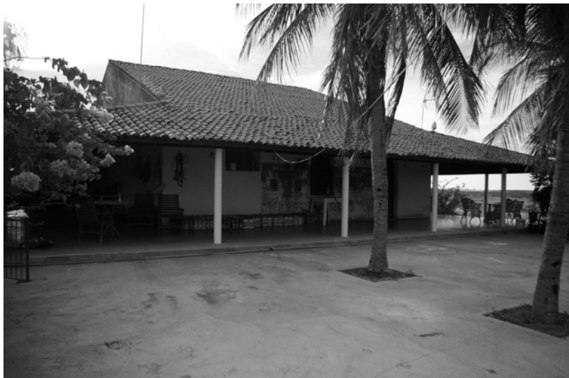
Foto 03 – Alpendre lateral (fotos dos autores)
